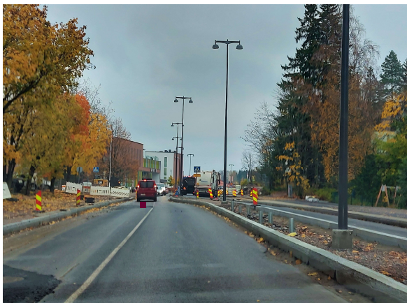
Helsingintien peruskorjaus rakenteilla 10/2020
